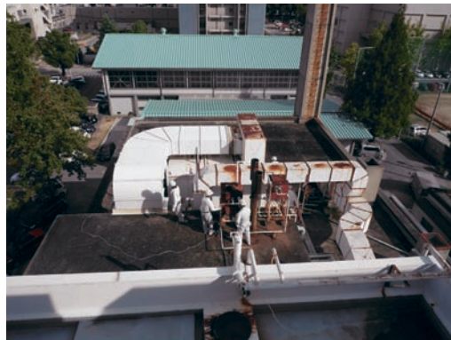
改修前の旧館屋上全熱交換器周り (平成21年10月撮影)
