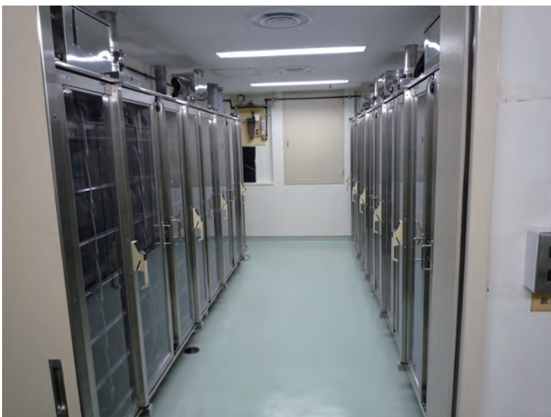
改修後の 417 室 (平成 22 年 12 月 18 日撮影)
