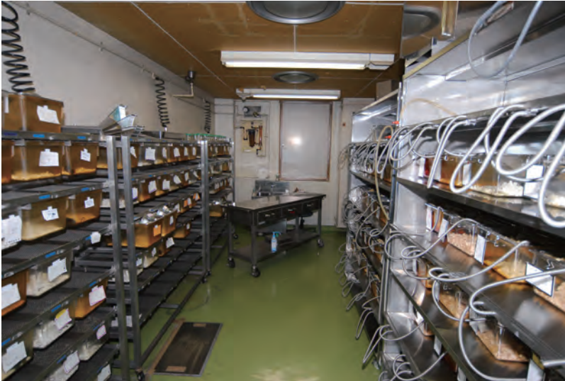
改修直前の 417 室 (平成 20 年 7 月 16 日撮影)
