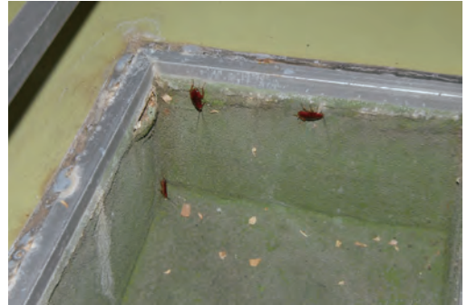
417 室排水ピット (平成 19 年 6 月 19 日撮影)
