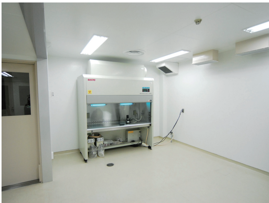
改装後の新 BSL-2 感染実験室 (133 室 & 134 室 + 廊下)
