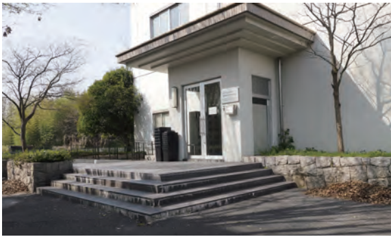
補修が完了した津島南施設玄関
