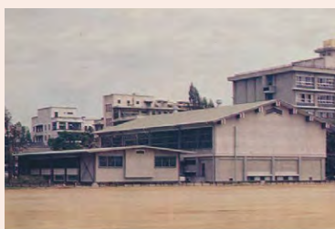
写真2) 完成直後の鹿田体育館と武道館
