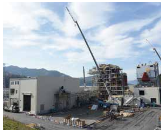
バイオマス発電所建設中
