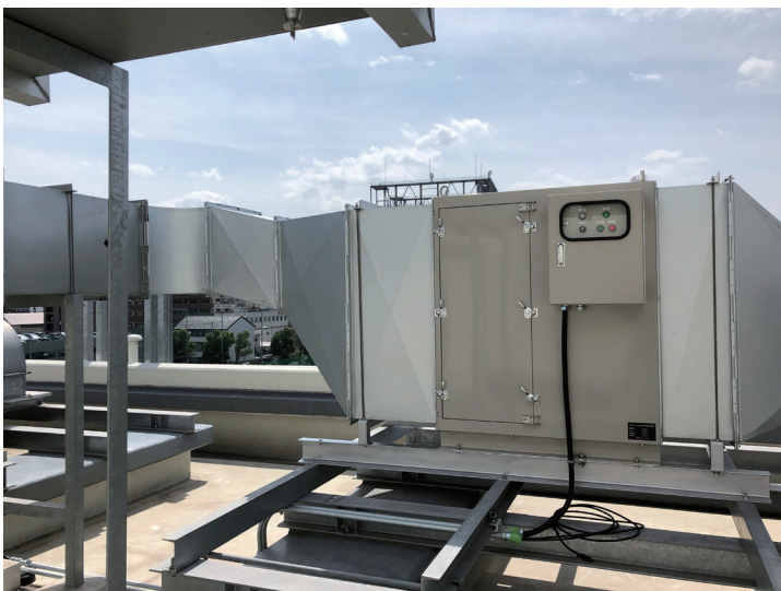
屋上に設置された脱臭装置
