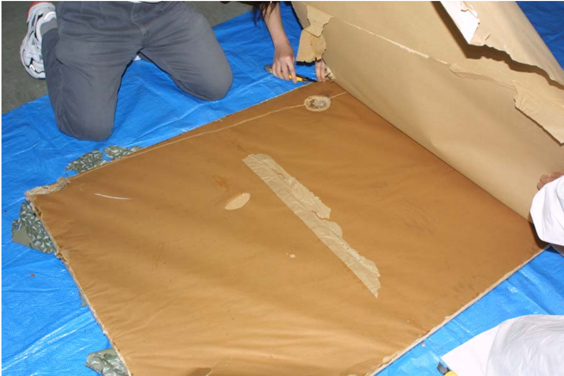
図 9 どうしても剥しにくい部分はカッターを使う
