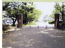
③ レンガ造りの門柱を有する門 現在、岡山大学構内で最も良好にのこっている門 である。門柱の両端の土型は逆「ハ」字状に、 内側にむかって狭まる構造となっている。 防衛のためであろうか。
