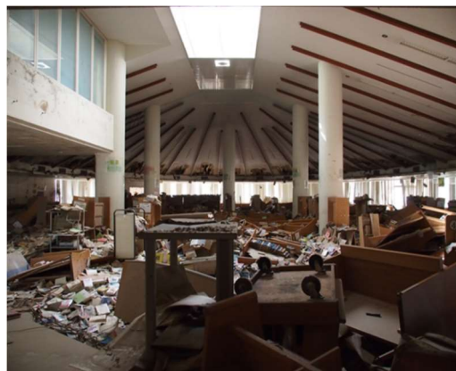
倉敷市立真備図書館の被災の様子
