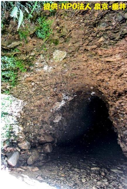
ルは、水源地と需給地を結ぶ水路の途中にある回避できない山を貫通させるためのものだが、マンボはトンネルそのものが伏流水や地下水を集水する目的で掘られた施設である。最も大規模な片
